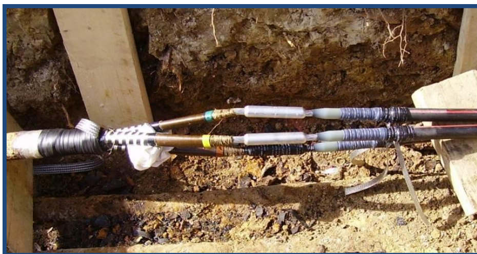
Figure 3. Photographie d'une transition en cours de fabrication.
